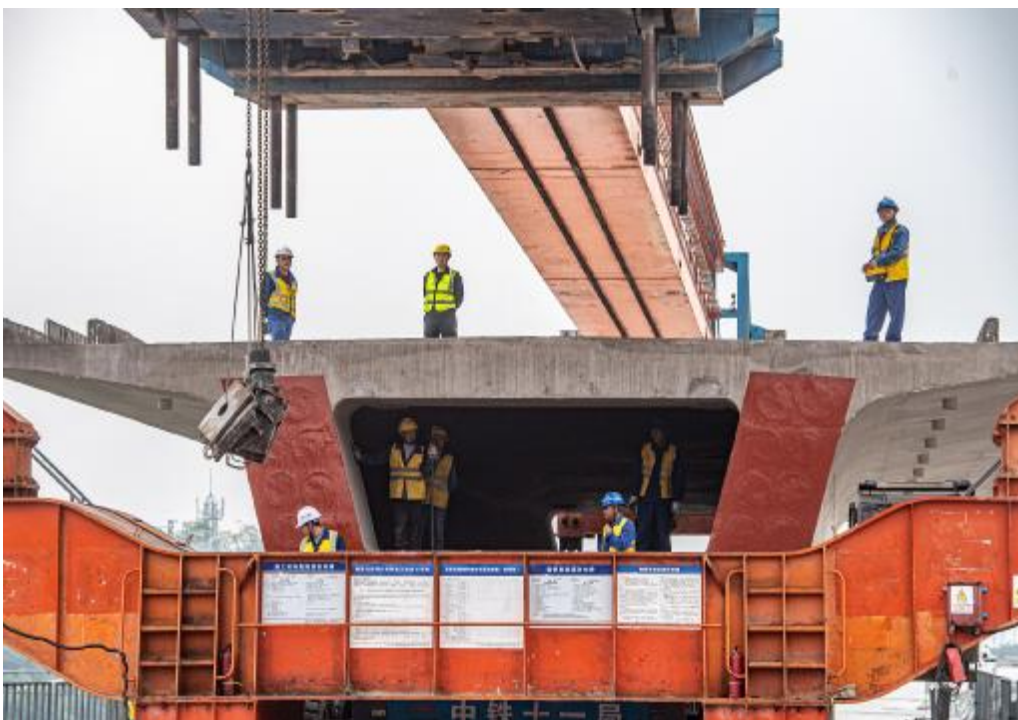
11月21日,在渝昆高铁川渝段梁湾特大桥建设施工现场,施工人员进行箱梁架桥作业。
