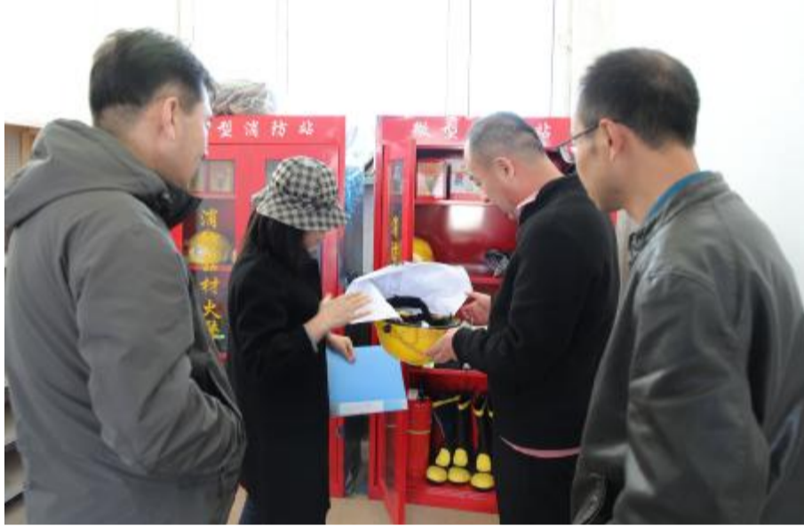
近期，大兴安岭农垦集团公司组成工作组，深入基层检查安全生产工作，排查安全隐患，营造和谐安定的生产环境。图为工作组检查安全生产储备库设施。 ■ 苑浩洋 摄
