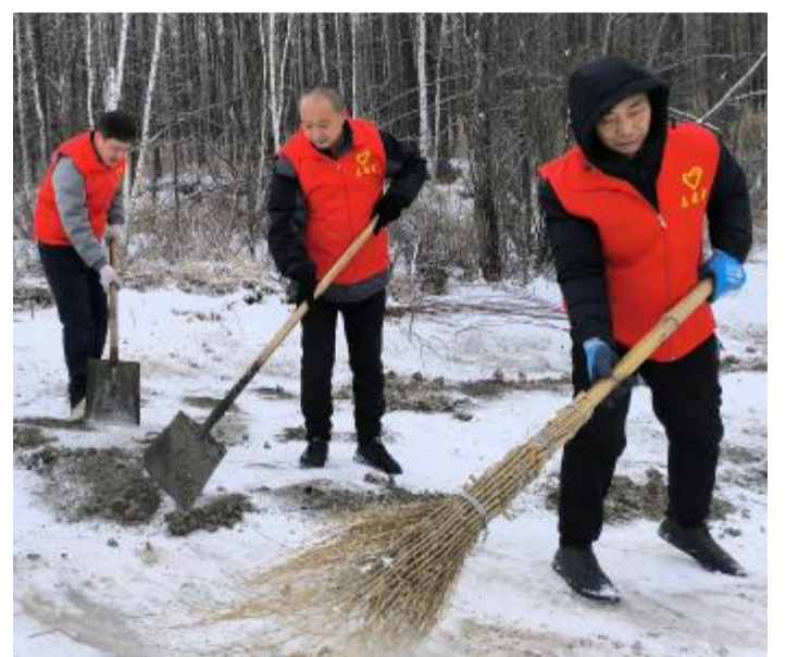
近日,图里河森工公司图里河林场新时代文明实践所组织志愿者到生态功能区41林班上坡路段铺设防滑材料,确保车辆行驶安全。 ■ 王晓刚 摄
