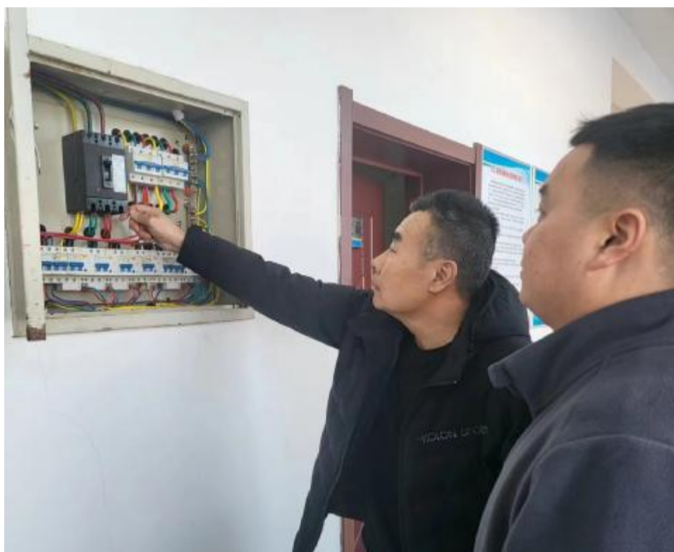
近日,毕拉河林业局有限公司大二沟林场开展安全隐患大排查,对林场、各管护站的锅炉房及配电箱等进行排查,对发现的问题逐一登记并明确整改时限。 ■ 孙琦夫 敖志宏 摄
