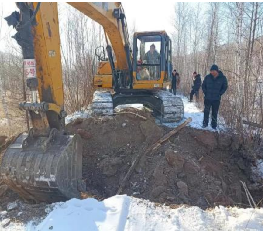
连日来，阿里河森工公司公路养护管理中心维修生态功能区损坏的道路和涵洞，为森林防火工作奠定坚实基础。
