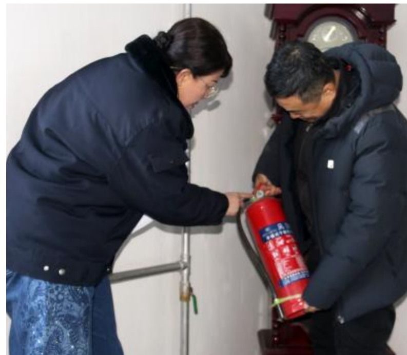
1月19日,吉文森工公司组织工作人员深入基层单位开展春节前安全生产检查,要求各单位做好防寒、防冻、防火、供暖、供电和预防经济火灾等各项工作,确保春节期间安全生产形势稳定。 图为工作人员检查消防器材。 刘志伟 王智非 摄
