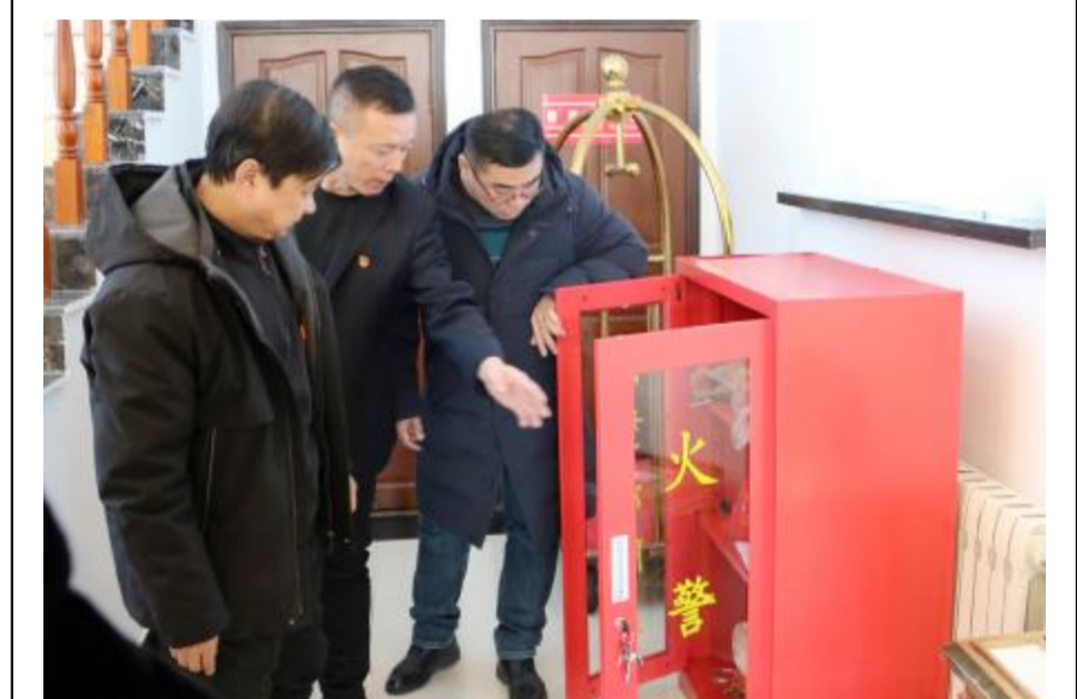
近日,莫尔道嘎森工公司安委办与镇供电所组成联合检查组,对公司各单位办公楼、车库和锅炉房等场所的电器设备、消防设备、特种设备以及输电线路进行“拉网式”大排查,防范各类安全生产事故的发生。王冠宇 摄
