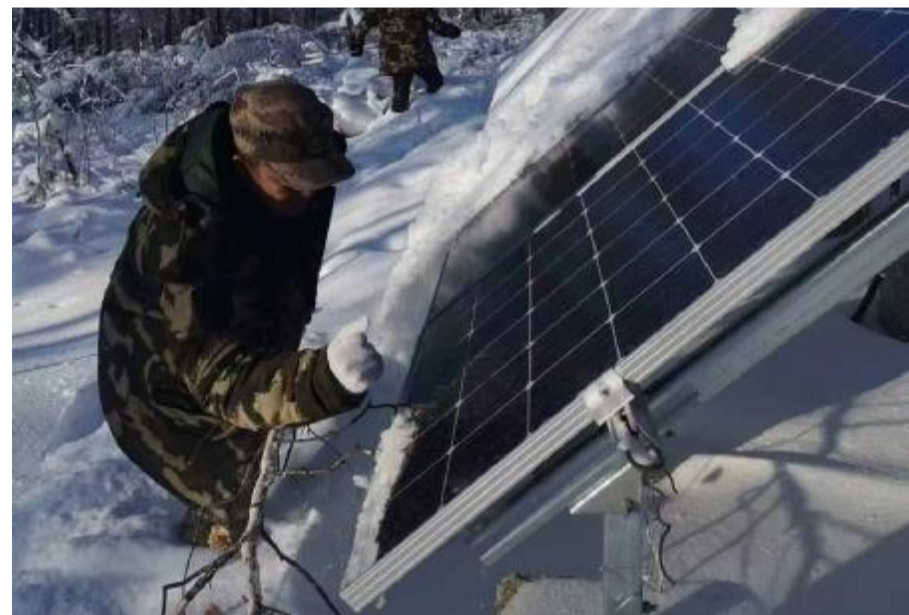
近日,为确保基站通信网络安全稳定运行,莫尔道嘎森工公司信息中心组织党员上山清理各基站太阳能板积雪。
