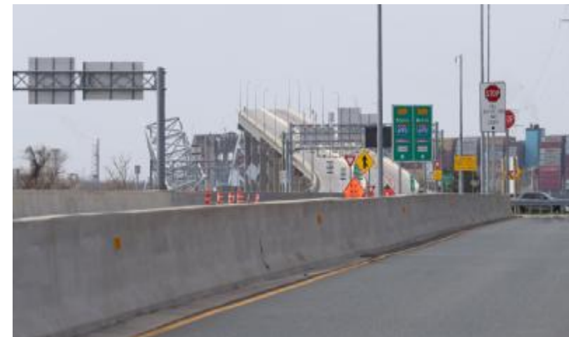
这是3月26日在美国马里兰州巴尔的摩拍摄的坍塌的大桥。美国东部马里兰州巴尔的摩一座大桥26日凌晨遭一艘集装箱船撞击后坍塌,恐有20人落水,搜救正在进行中。新华社记者 胡友松 摄
