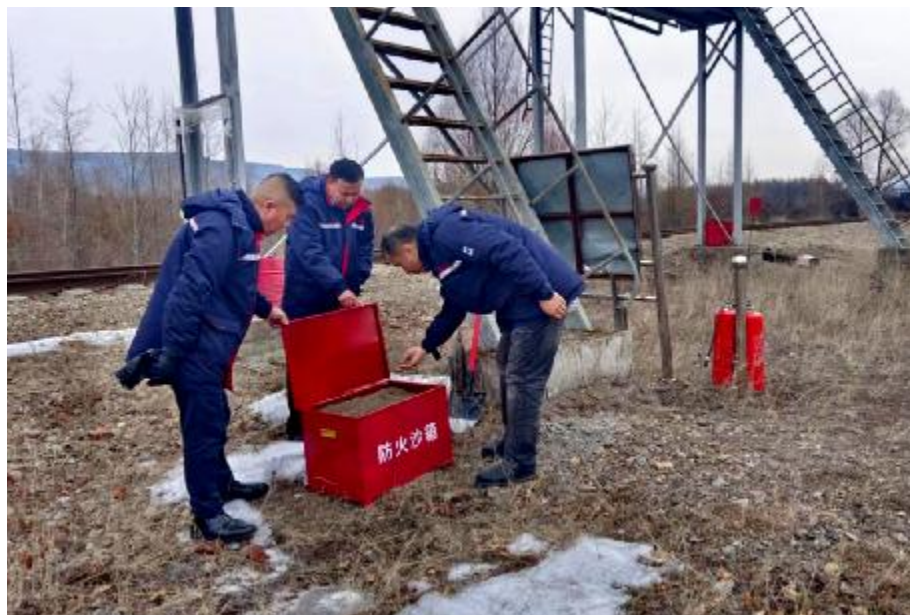
近日,莫尔道嘎森工公司物资供应处夯实“人防+器防”应急救援体系,将经过晾晒、干燥过的防火沙重新过筛装箱,为卸油栈桥更新8公斤灭火器,落实专人巡护,从源头抓好春季森林防火工作。 ■刘峰 摄
