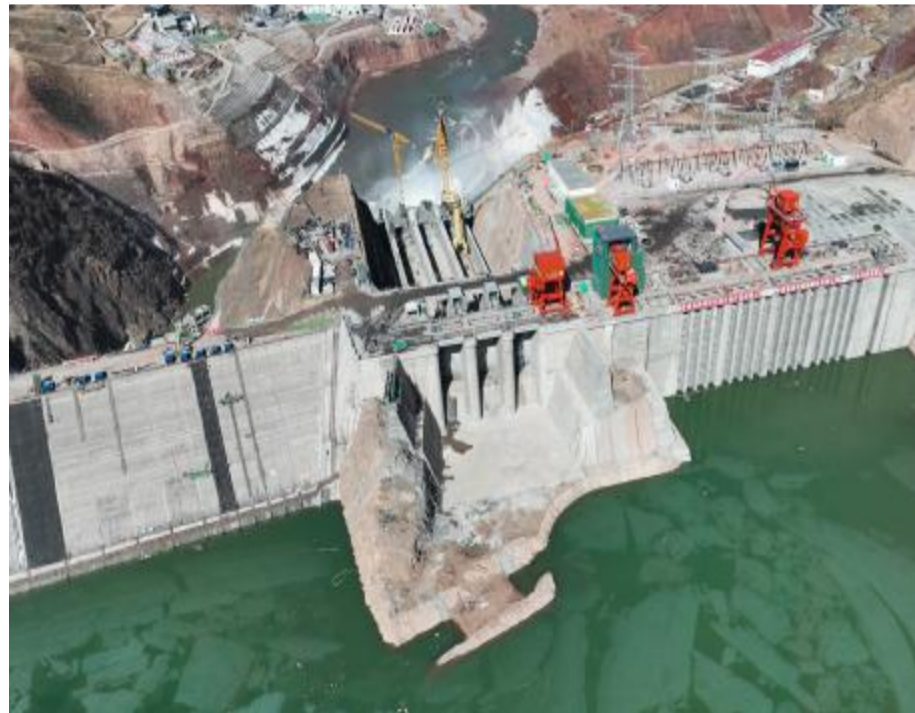
这是4月1日拍摄的玛尔挡水电站(无人机照片)。4月1日,玛尔挡水电站首台5号机组正式并网发电。该水电站位于青海省海南藏族自治州同德县与果洛州玛沁县交界处的黄河干流上,项目所在地平均海拔3300米,总装机容量232万千瓦,是黄河流域在建海拔最高、装机最大的水电工程,属于国家和青海省重点能源项目,也是国家实施“西电东送”和“青电入豫”的骨干电源点,电站预计2024年12月实现全部机组投产发电。
