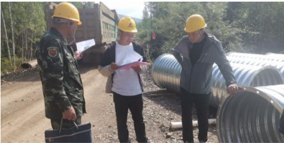
近日,根河森工公司应急事务中心对森林防火应急道路建设项目现场的机械设备、消防设施、安全标识、人员作业安全等方面开展防火安全联合检查,对施工期间森林防火、安全生产等工作提出整改意见,并现场督促整改到位。 ■王聪 摄
