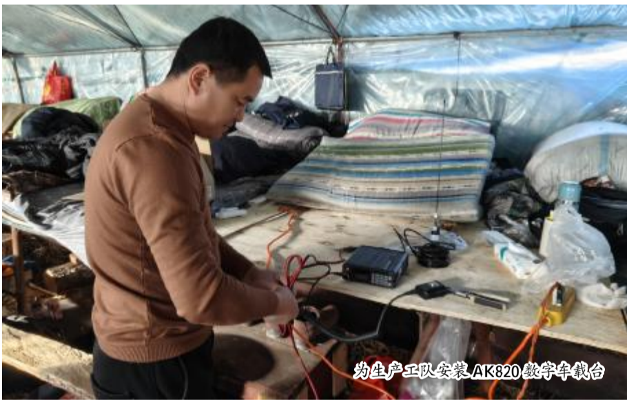
为生产一线工队通信设备安装太阳能供电系统
