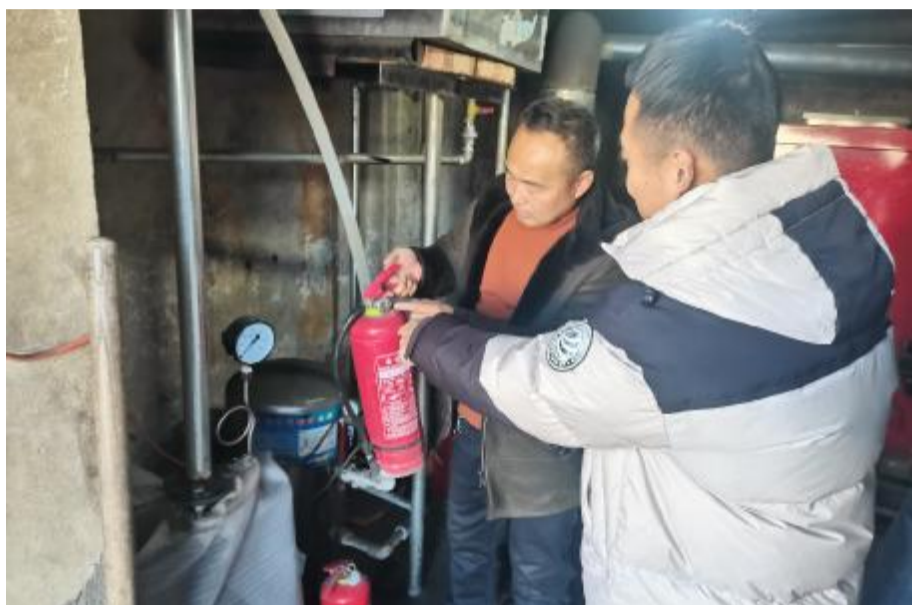
近日,大杨树林业公司宜里林场组织人员检查锅炉、燃气管道、消防器材等设备,对存在的安全隐患立即整改。图为工作人员在查看消防器材。 ■ 秦芹 摄
