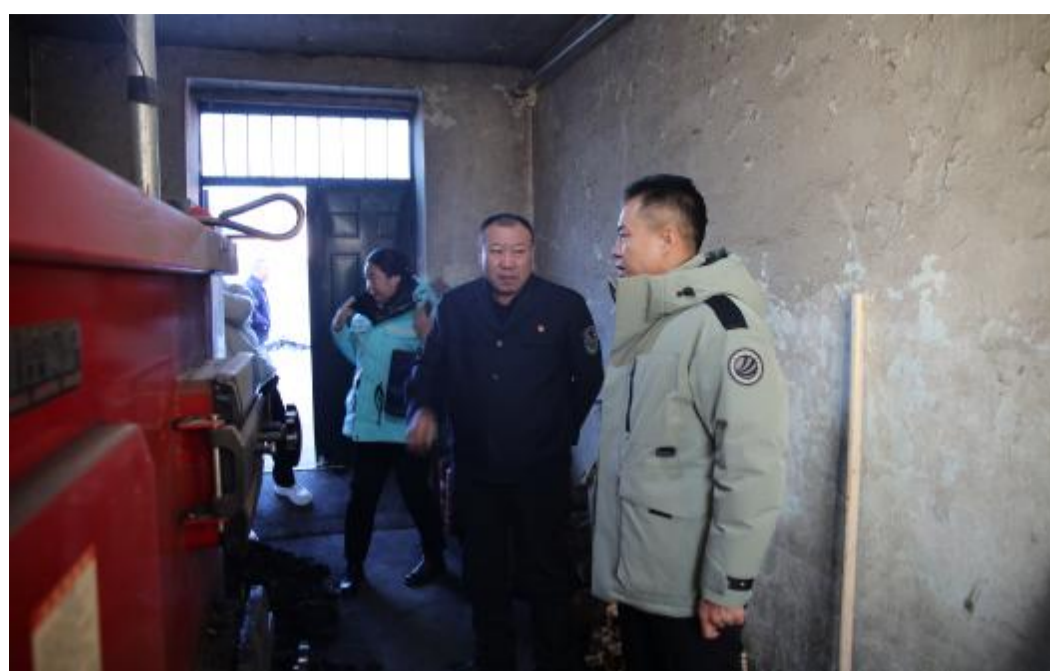
近日,大杨树林业公司工会组织员工代表深入基层单位开展安全巡视工作,对各单位车辆状况、锅炉运行、用电用气安全、消防设施配备等情况进行细致检查,提升员工安全防范意识,杜绝各类安全事故发生,保障员工的生命财产安全。图为员工代表检查锅炉运行状况。
