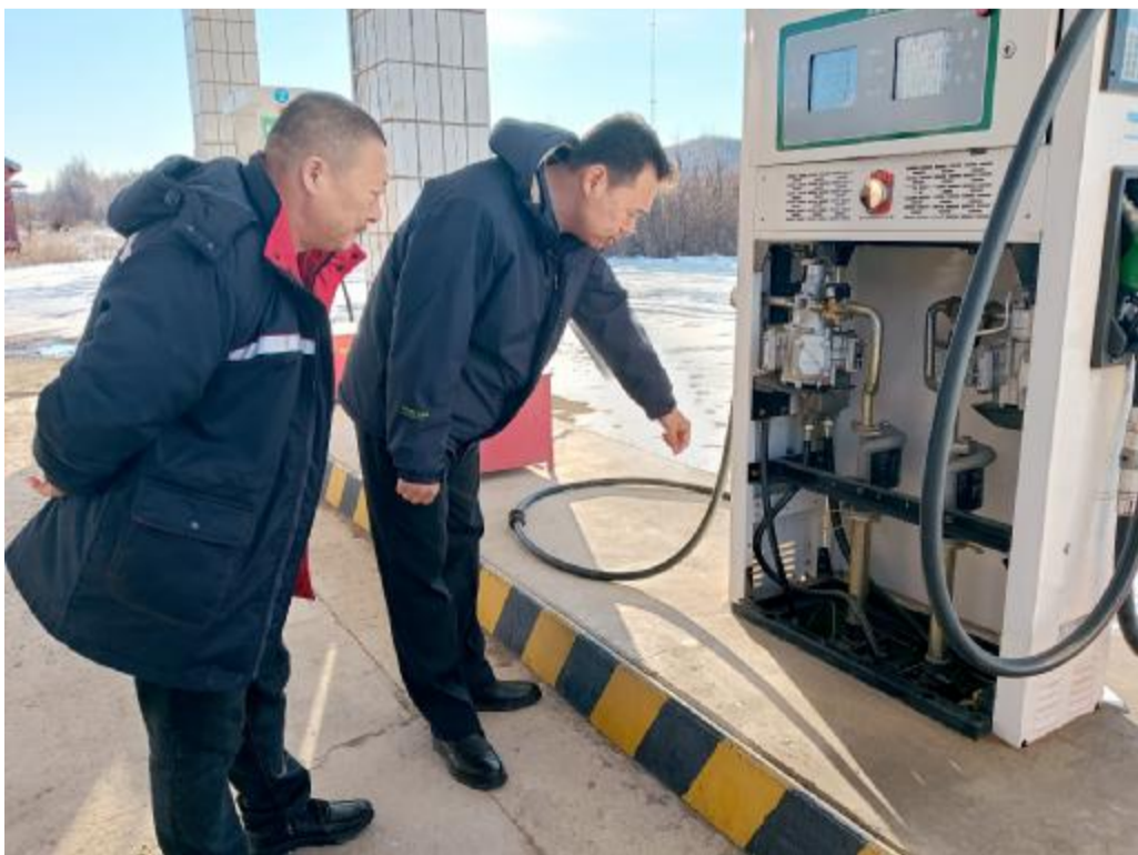
近日,莫尔道嘎森工公司安委办开展安全生产检查,重点检查森林抚育作业区设备与人员防护装备、人员密集场所消防设施和用电安全等,筑牢安全生产根基,保障各项工作有序进行。图为工作组在加油站检查加油机。阿力木苏 摄
