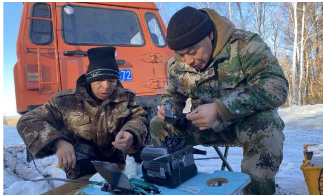
近日,大杨树林业公司应急事务中心通讯保障小组来到奎中林场,开展通信维修保障工作,确保通信畅通无阻。 图为工作人员对断裂的光纤进行熔接处理。 ■ 习慧琳 摄
