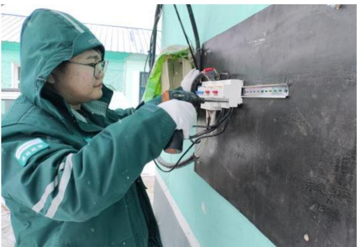
近日,大杨树林业公司宜里林场开展宿舍、食堂等重点区域用电线路排查工作,更换配电箱1个、漏电保护器3个,消除用电安全隐患。 ■金玉良 摄
