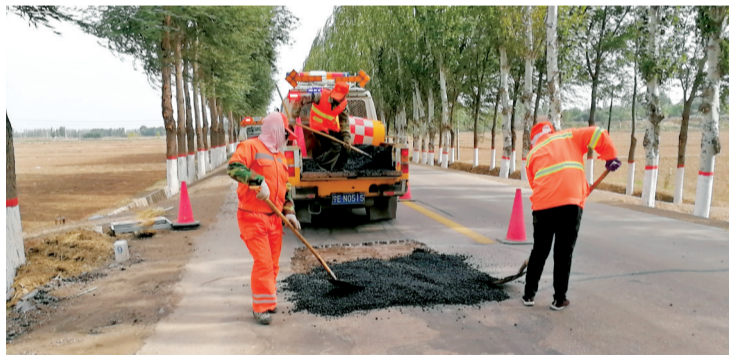
宁夏公路管理中心中宁养护中心,近日开展了秋季公路养护大整治,加强路面清扫保洁,及时维修路面病害,做好道路绿化管护和桥梁养护,加大路域环境整治,创造良好的公路通行环境。图为职工对路面病害进行处置。张婧摄
