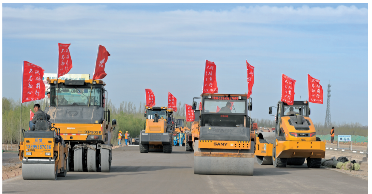
今年以来,我区交通运输行业积极克服疫情不利影响,着力推进交通基础设施建设,截至4月上旬,全区公路水路交通固定资产投资10.1亿元,其中4月上旬完成投资2.6亿元。图为筑路机械在京藏高速改扩建工程沙湖互通立交施工。毛永智 摄
