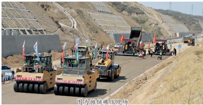
图为摊铺碾压现场
