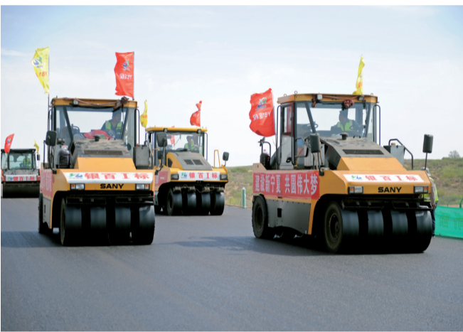
图为路面摊铺碾压。
