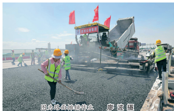
图为路面摊铺作业 廖波摄
