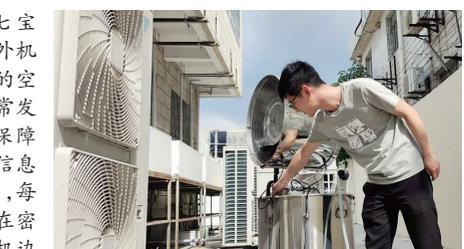
风机为空调外机降温，今年夏天，七宝IDC机房未出现一次因空调外机过热停机导致的机房温度上升情况，确保了机房设备正常运行。(费烈铭) (未完待续)
