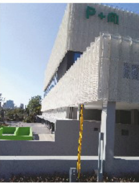
苏州市首家 P + R 停车楼亮相高新区竹园路。位于竹园路北,新升新苑南门东,是一座现代化立体智慧停车大楼。停车楼停车方式是“激光导航+梳齿交换”形式停车。通过搬运器和座位上互相交叉的梳齿机构实现车辆的位置交换,更安全、快捷,全流程取车时间
