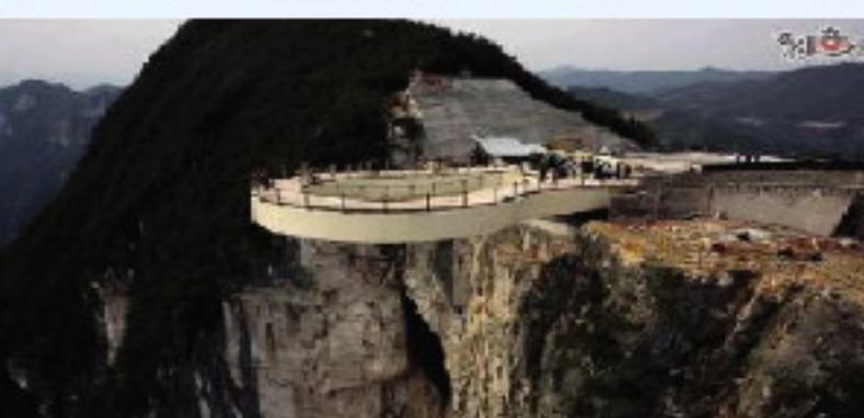
陡峭的山顶崖壁上，工人们硬生生敲出了一块数百平米的开阔平台，结合现代化的工艺，用钢筋水泥浇筑成一朵线条感十足的‘悬崖之花’，柔美与刚劲相结合，让人惊叹。
