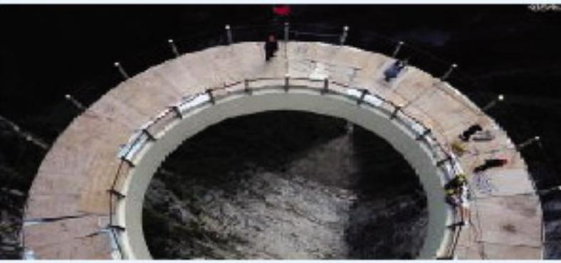
桥桥的地面、护栏采用的均是3层钢化夹胶超白玻璃。这种玻璃本身的承重性非常好，每平方米承重高达9吨，整个廊桥几乎可以承重达1000多吨。玻璃中的高强度胶，安全系数也非常高，即使玻璃损坏了，单靠胶的张力就能拖起人和玻璃的重量，人踩在上面也不会垮塌。
