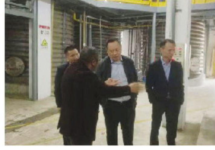
为抓好特种设备安全工作,吴中区市场监管局由稽查文副局长带队,走进吴中开发区高隆港苏州有限公司、城南仓储部等企业开展特种设备安全检查。
