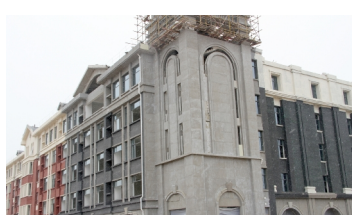
济南一中分校建设项目一角
