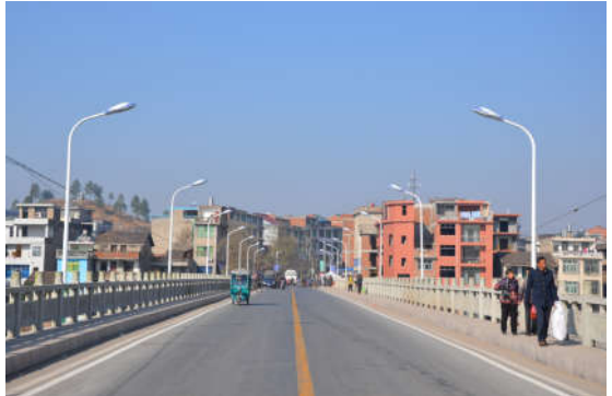
改造扩建后的五都大桥。
