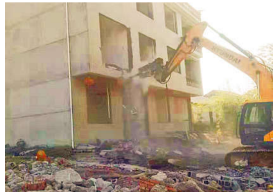
房屋拆迁现场。
