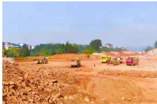
辉腾路施工现场。
